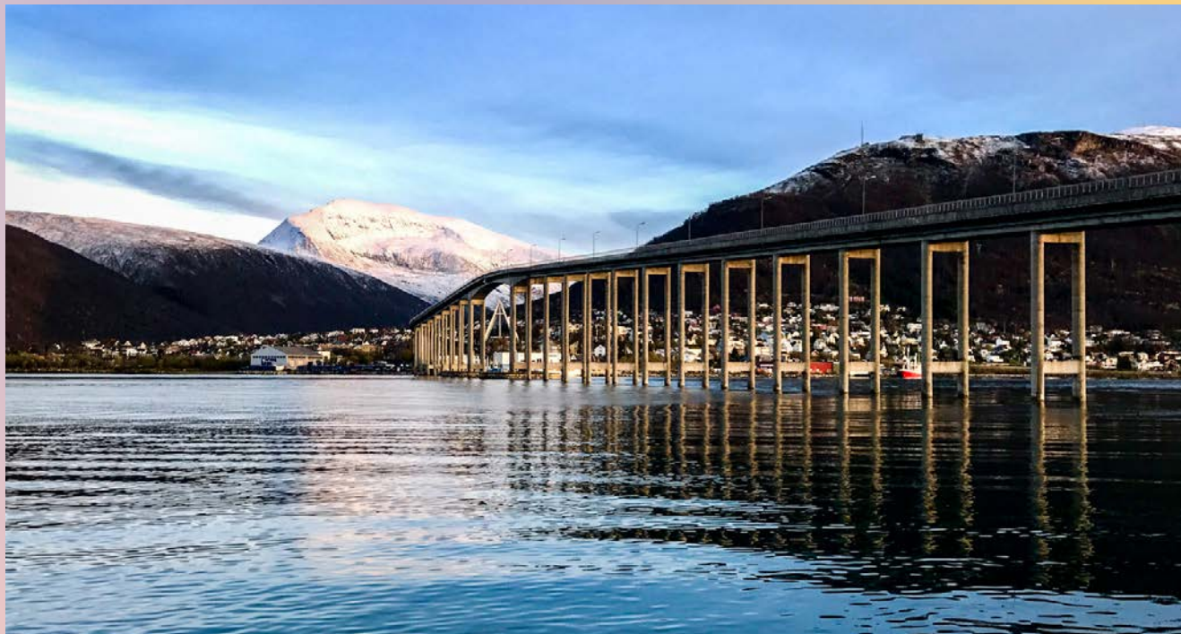
Tromsøysundet med brua
