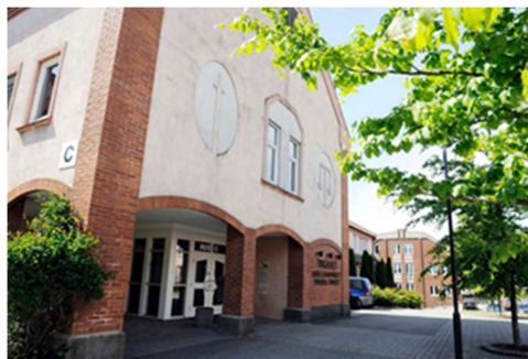
Tinghuset i Husvikveien 167, Tønsberg.
