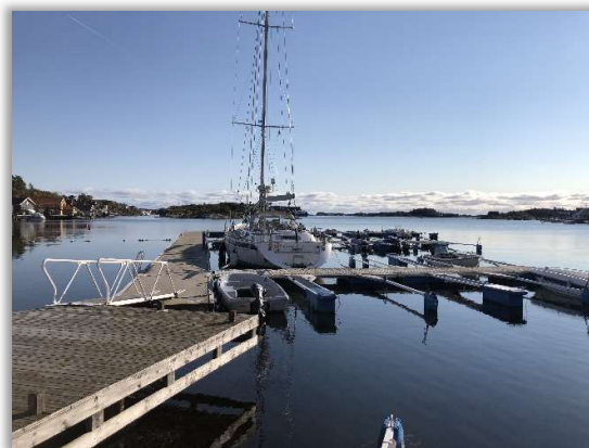
Deler av bryggeanlegget Skjærgårdsparken, Flekkerøy.
