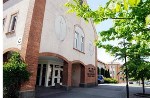
Tinghuset i Husvikveien 167, Tønsberg.
