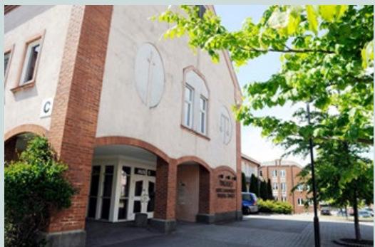
Tinghuset i Anton Jenssensgate 9, Tønsberg. Nytt tinghus i Tønsberg er under bygging og vil tas i bruk fra august 2025
