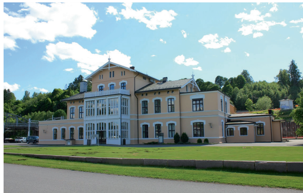
Lagmannsrettens hus, Eidsvoll
