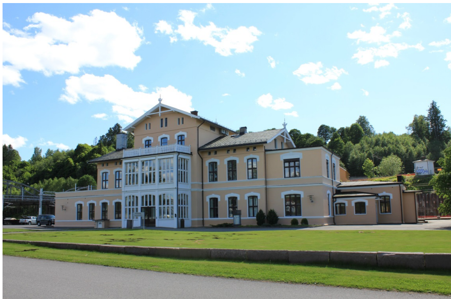
Lagmannsrettens hus, Eidsvoll
