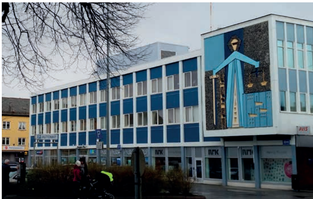
FRU JUSTITIA I KRISTIANSUND: Det gamle tinghuset på Kongens plass i Kristiansund ble tatt i bruk av Nordmøre tingrett (herredsrett) i 1968. Det er ett av de sene «gjenreisningsbyggene». Dekorasjonen «Fru Justitia» på ytterveggen ble laget av kunstneren Aud Volckmar (1923–2003). Bygget ble benyttet som rettslokale også av Frostating lagmannsrett i sivile saker. Nordmøre tingrett (herredsrett) flyttet 1. januar 1991 til det nye tinghuset i Storgata. Siden har også Frostating lagmannsrett holdt ankeforhandlinger både i sivile saker og straffesaker der.
