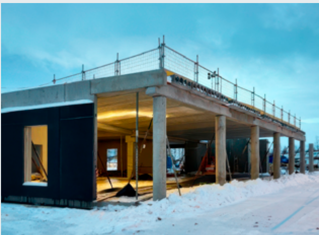
Bygging av rettslokalene i Alta. Foto: Torbjørn Saggau Holm
